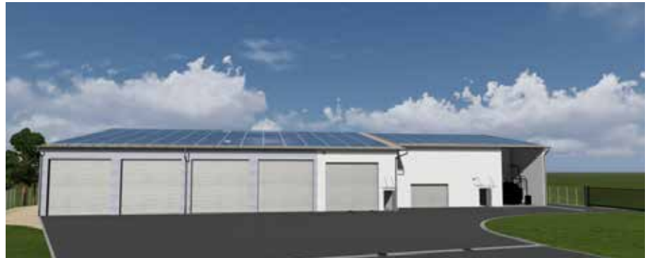
Frontansicht der neuen Kläranlage und Bauhofhalle
