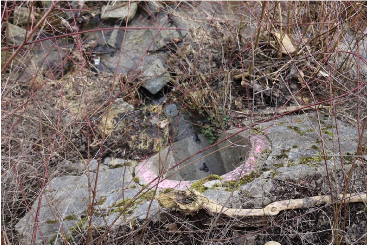
Abbildung 5: Foto bestehende Einleitungsstelle ERW2 nahe Herbststraße, Bayerbacher Bach
